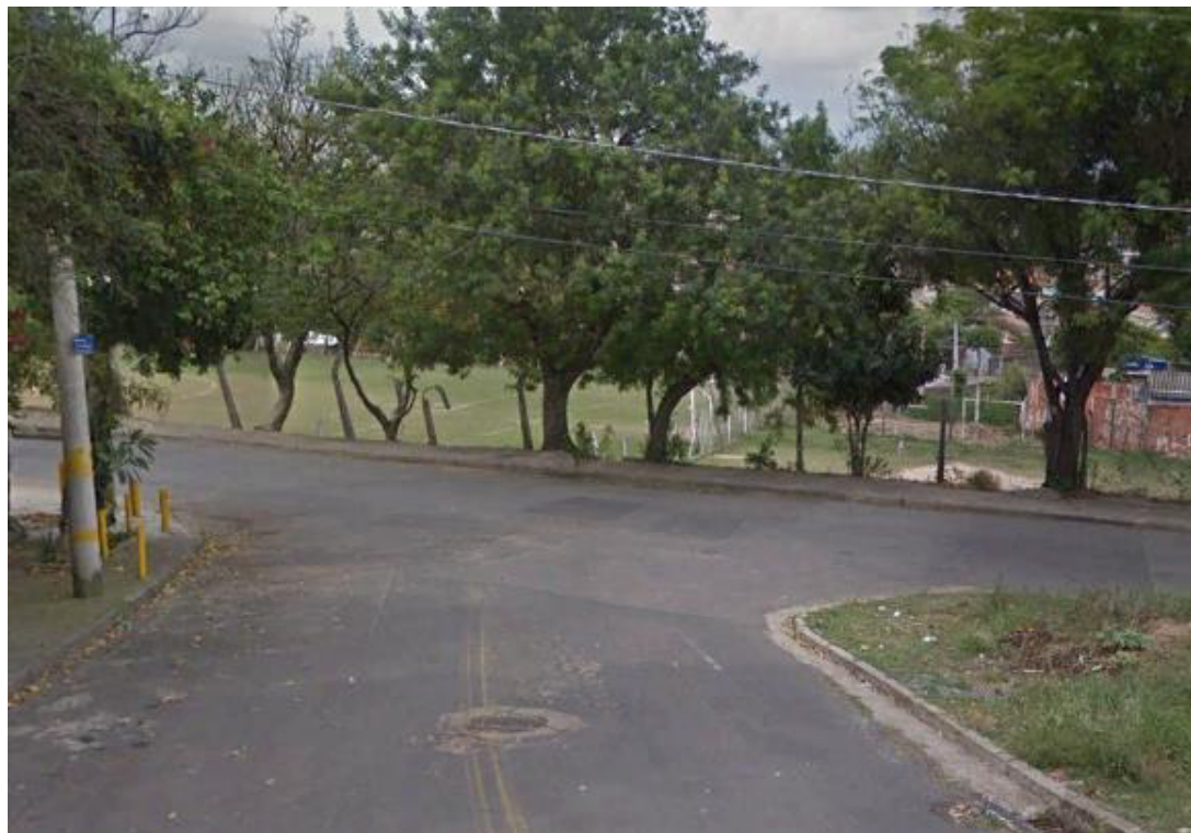
Figura 18. Vista geral da Avenida Embarque Sãmia Zarur com a Rua Manoel de Aquino Pereira.
