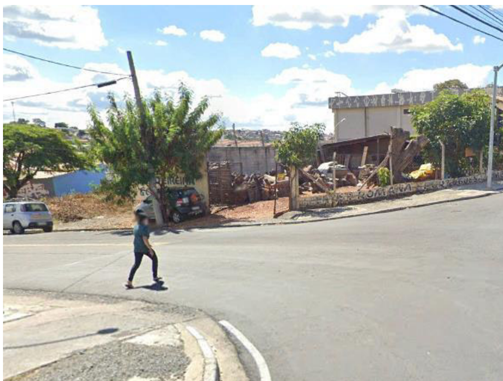
Figura 20. Vista geral do cruzamento da Avenida Ruy Rodriguez com a Av. Profa. Maria Julieta Godoi Cartezani.
