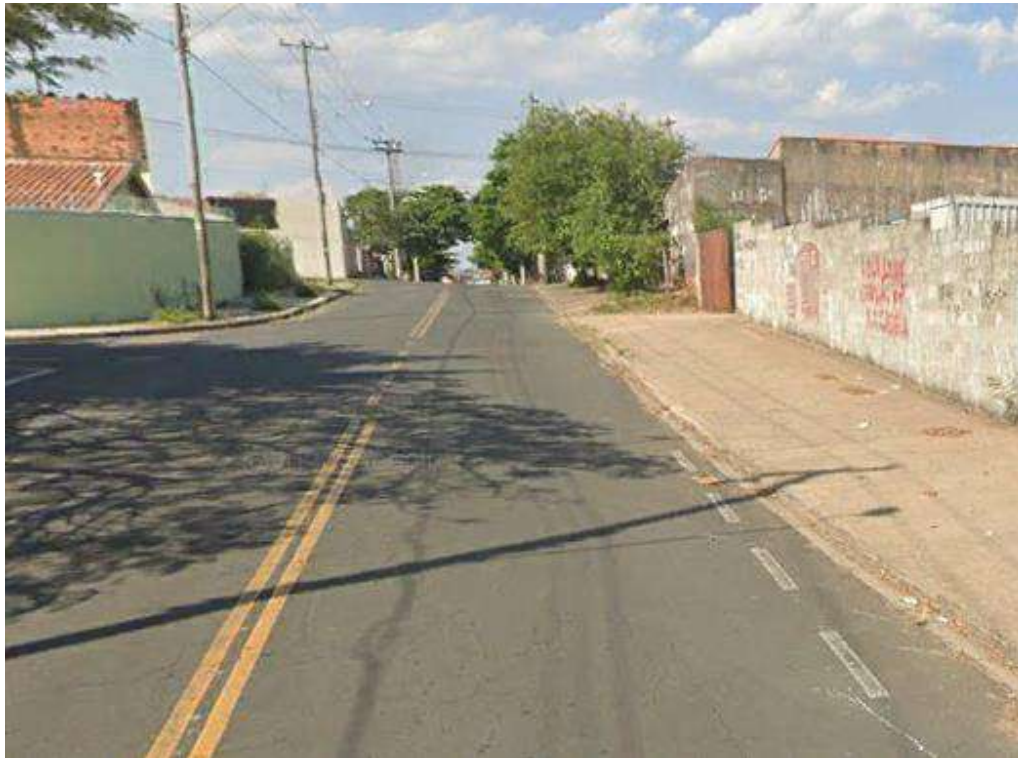
Figura 11. Vista geral da Rua Manoel de Aquino Pereira.
