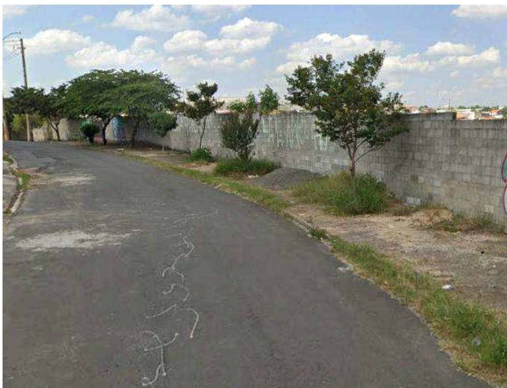
Figura 10. Vista geral da Rua Manoel de Aquino Pereira.
