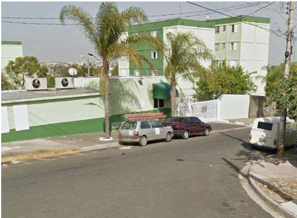
Figura 7. Uso residencial multifamiliar na Rua da Padroeira.
