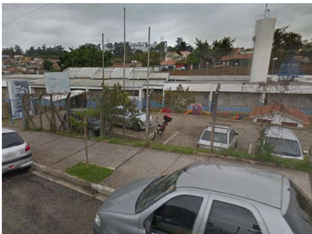
Figura 8. Área institucional na AII – Rua Francisco Delfino.
