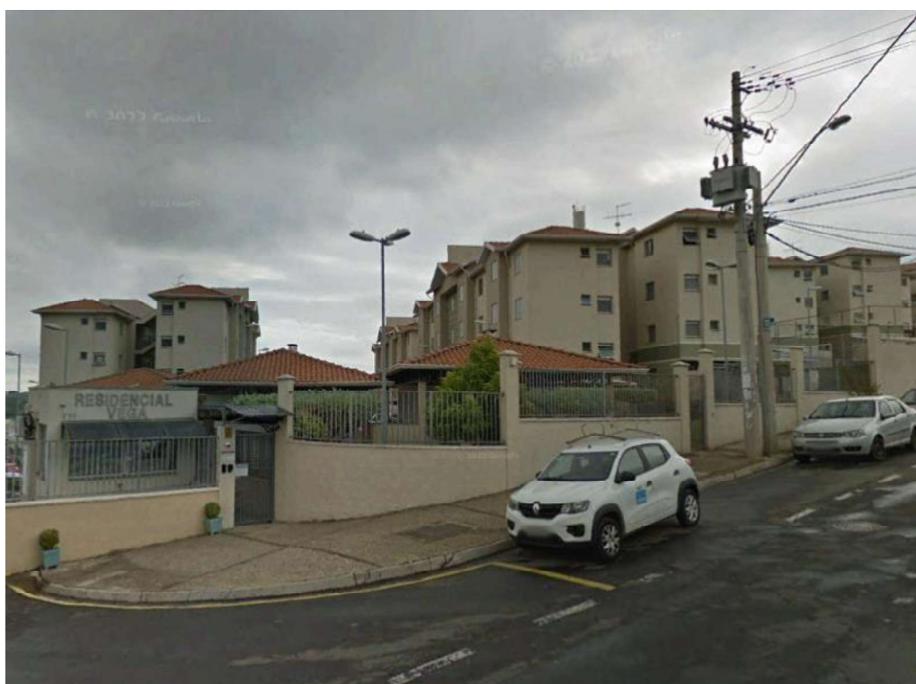
Figura 9. Residencial multifamiliar encontrada na AII – Rua José Humberto Bronca.
