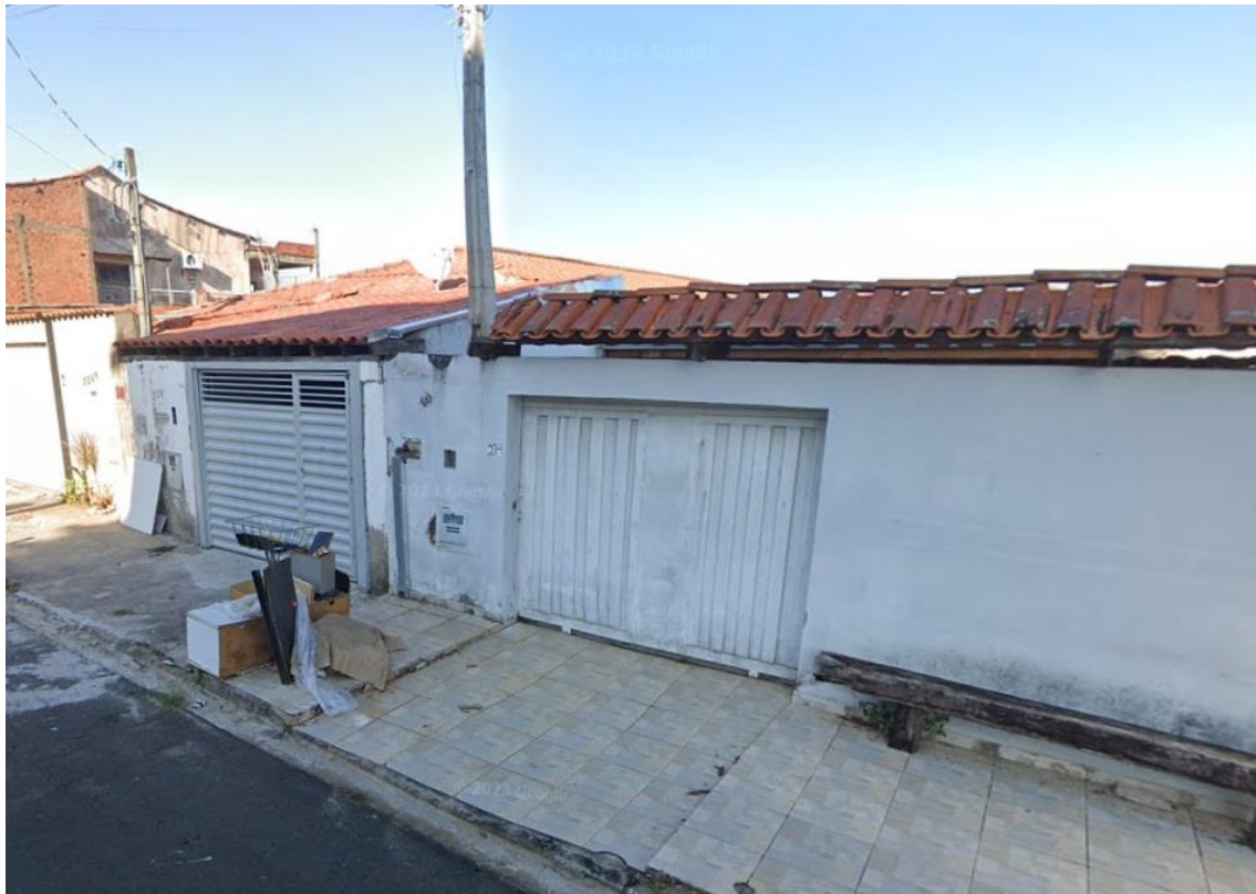
Figura 9. Residência unifamiliar – Rua Capixaba.
