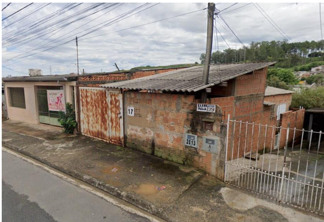
Figura 18. Ocupação irregular – Rua Elias de Oliveira Sabóia.
