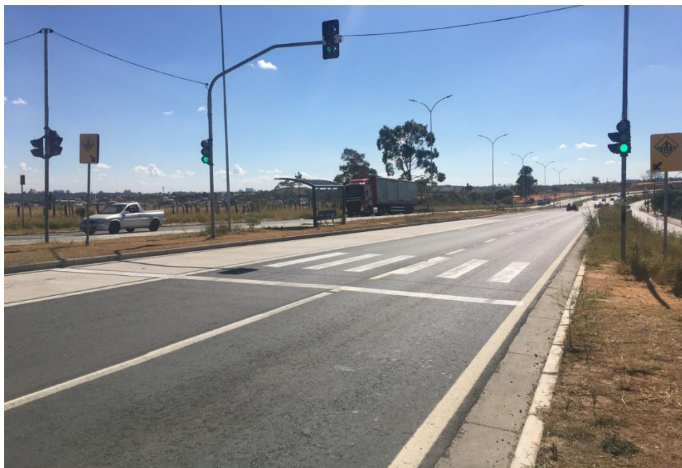
Figura 22. Vista geral da Avenida John Boyd Dunpod, com ótimas condições de pavimentação, bem como com a sinalização vertical, horizontal e semafórica adequada, após revitalização.
