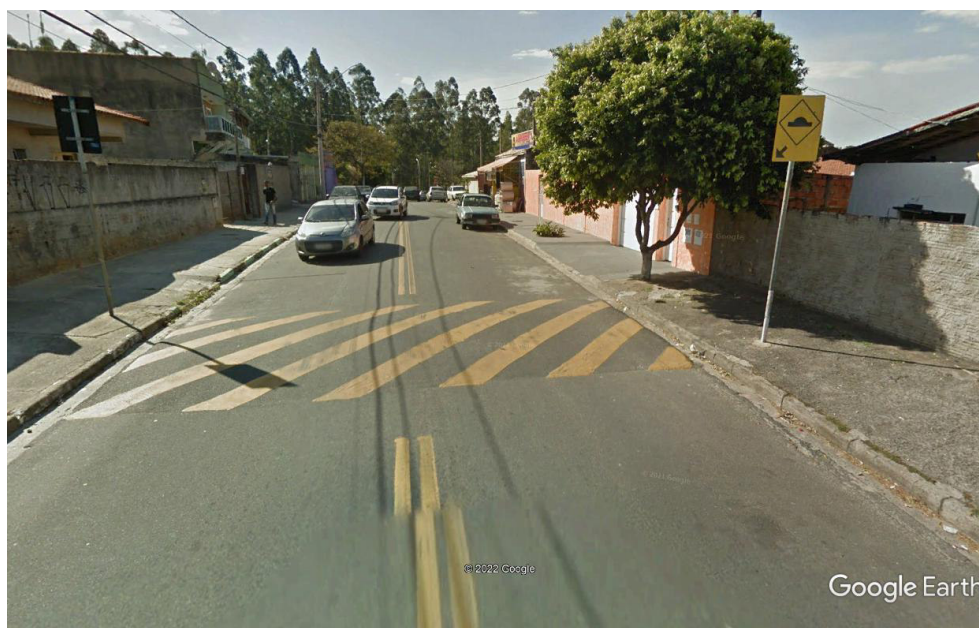
Figura 24. Lombada na rua Rua Benedito Franco.
