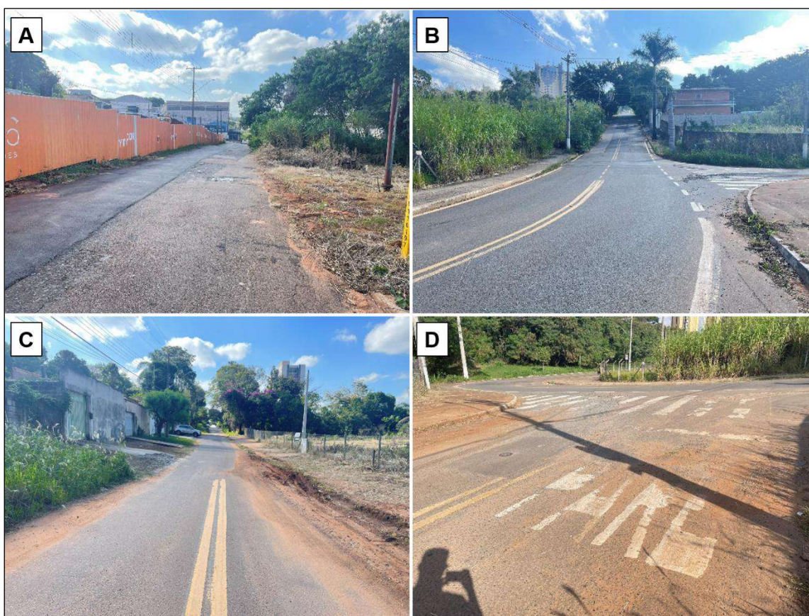
Figura 10. (A) Rua José de Freitas Amorim na área em frente ao futuro empreendimento, (B) Vista sentindo oeste da Rua Arquiteto José Augusto da Silva, (C) Vista sentindo norte próximo à Rua Arq. José Augusto da Silva, (D) Sinalização horizontal precária.
