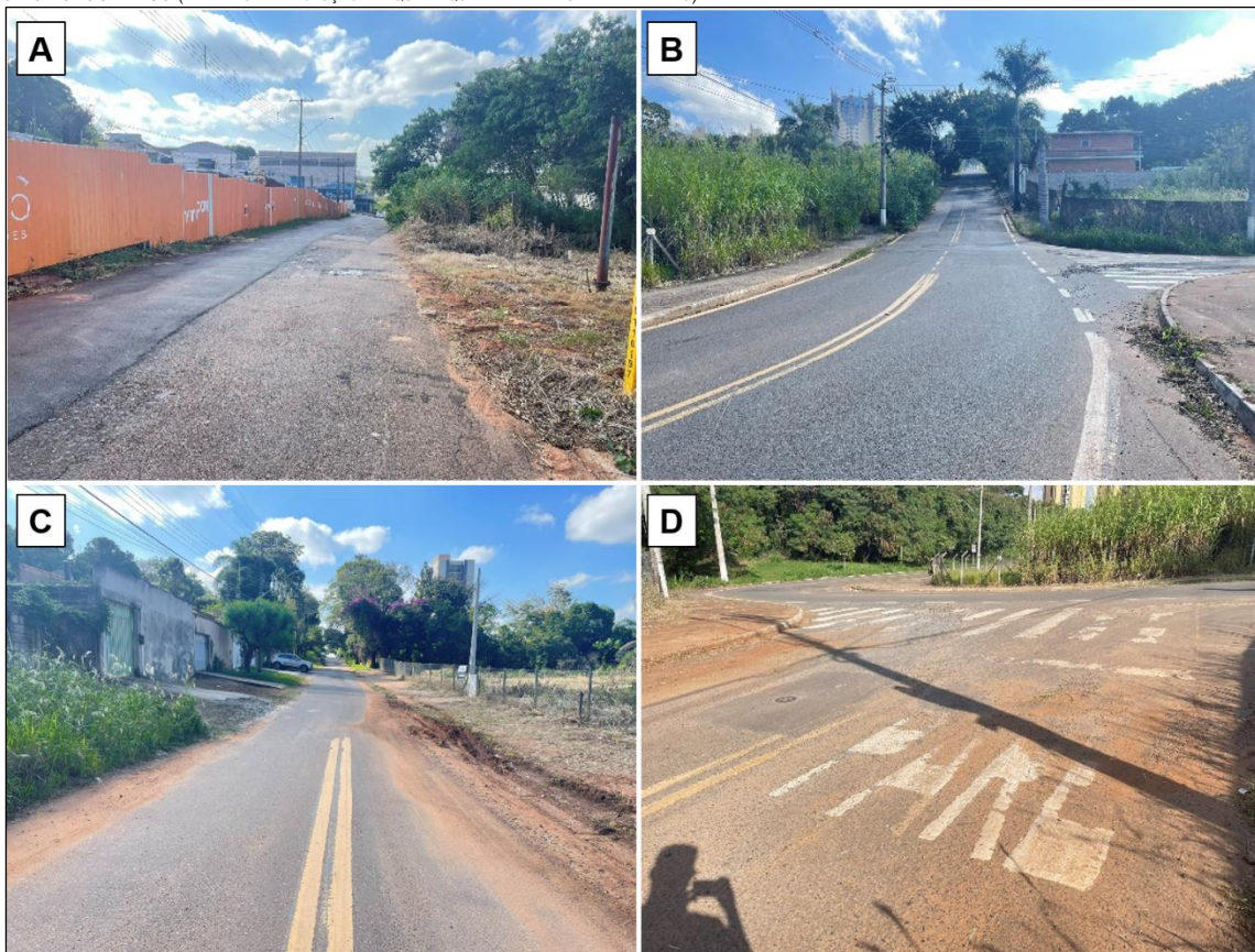
(A) Rua José de Freitas Amorim na área em frente ao futuro empreendimento, (B) Vista sentido oeste da Rua Arquiteto José Augusto da Silva, (C) Vista sentido norte próximo à Rua Arq. José Augusto da Silva, (D) Sinalização horizontal precária.
